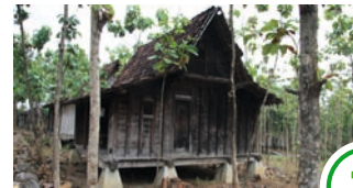
Abriss des Holzhauses
