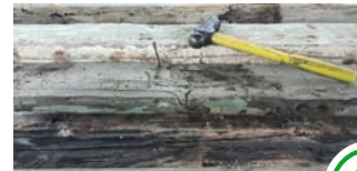
Entfernen von Nägeln, Schrauben und anderen Verbindungselementen
